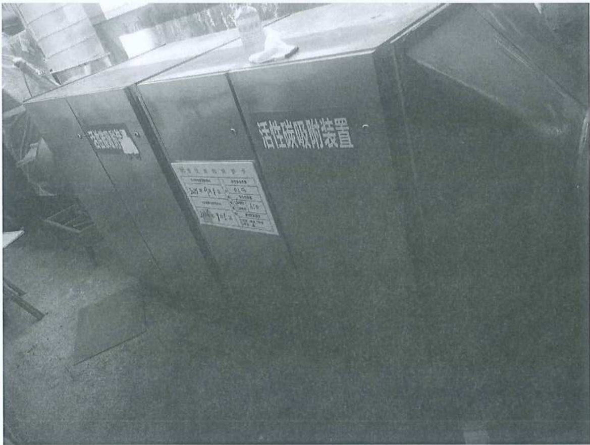
图 4.2 开炼及硫化工序有机废气治理设施图
