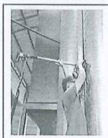
锯板工序废气排放口
